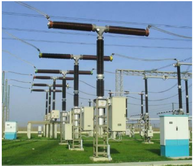
Fig. 3.7. 400 kV circuit breakers
