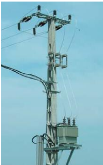
Fig. 3.3. Pole transformer, 22/0.4 kV, 250 kVA
